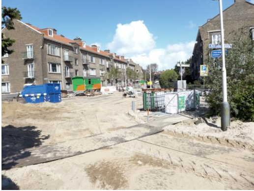
Vervanging riolering Arabislaan
