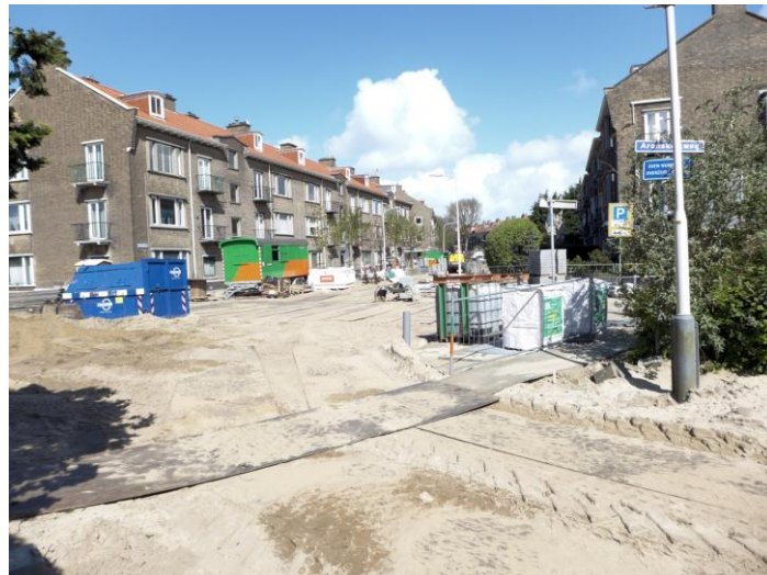
Vervanging riolering Arabislaan
