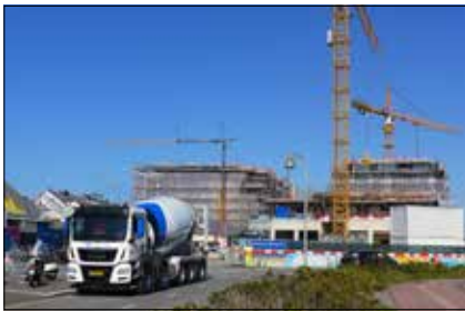
Op de voorgrond fase 1,5, links gebouw Vendaval in wording
