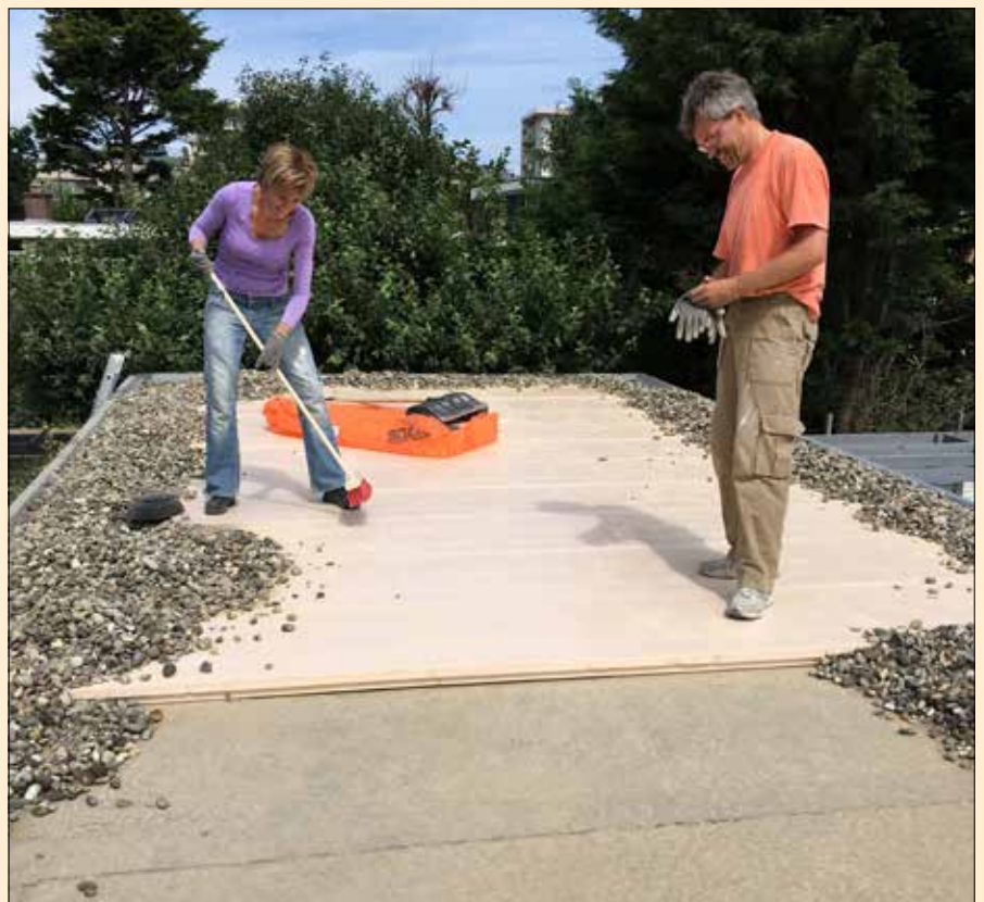
Ronald en zijn zus Charlotte brengen dakisolatie aan op zijn woning
